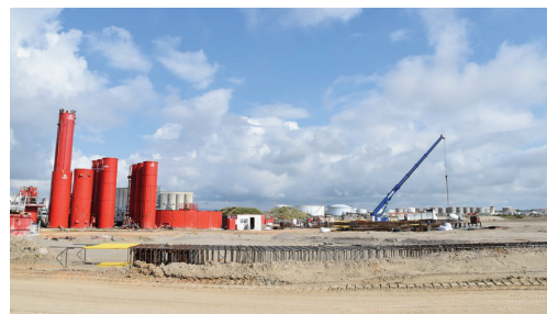
Aménagement du port de Port-la-Nouvelle
