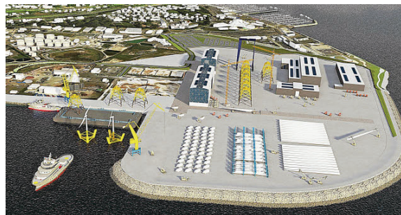
Travaux en cours pour la réalisation d'un polder sur le port de Brest visant à attirer les activités liées aux énergies marines
