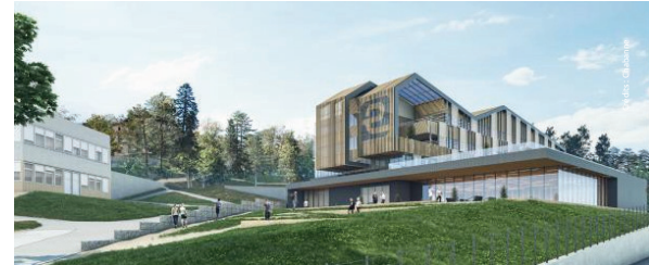
Enedis réaffirme son engagement en faveur de l'apprentissage et la transmission des savoir-faire au sein de l'entreprise, fil rouge du Projet Industriel et Humain 2020-2025 avec par exemple le projet de modernisation d'un de ses campus, La Pérolrière, lancé en 2021.
